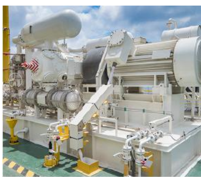
图 18： 蒸气回收装置
