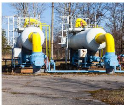
图 17： 天然气压缩机站
